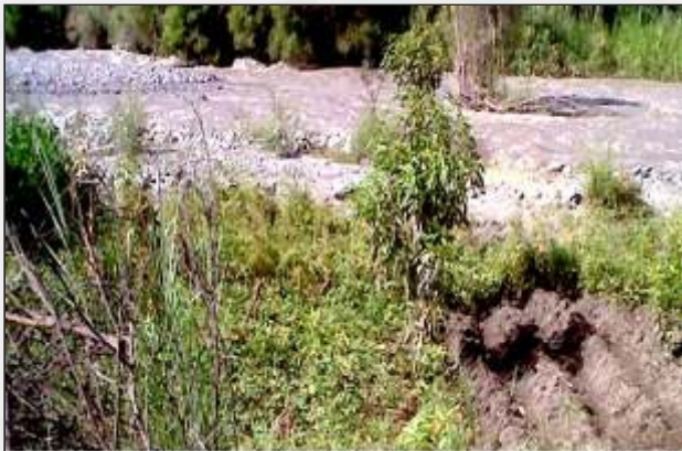
Figura 3. Daños de la ribera por cambio de uso del suelo por pequeños campos de cultivo.
